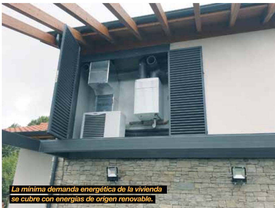
Una bomba de calor aerotérmica y un recuperador de calor integran la instalación de climatización y ventilación.
