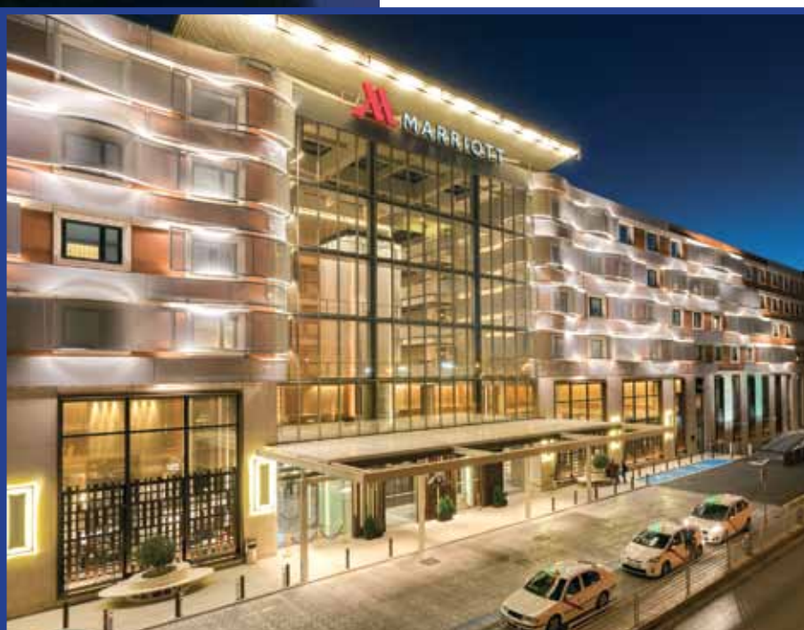
En la mayoría de las rehabilitaciones se interviene en la iluminación.
