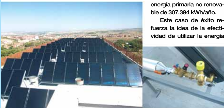
Figura 3. Instalación de los captadores solares en la cubierta.
