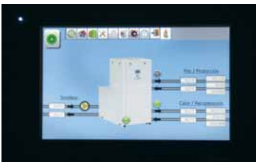
El equipo se conecta a los circuitos de demanda de calor y frío de la subcentral térmica.
