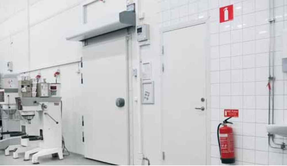
Una de sus principales aplicaciones es en cámaras frigoríficas.
